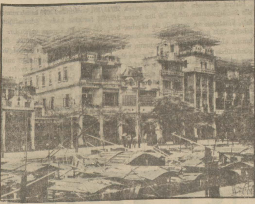
Japon tayyareleri tarafından yapılan hava bombardımanlarından korunmak üzere, Kantondaki mühim binaların çatıları üzerinde yapılan kamıştan siperler
